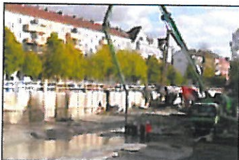
Sauberheitsschicht Bodenplatte
