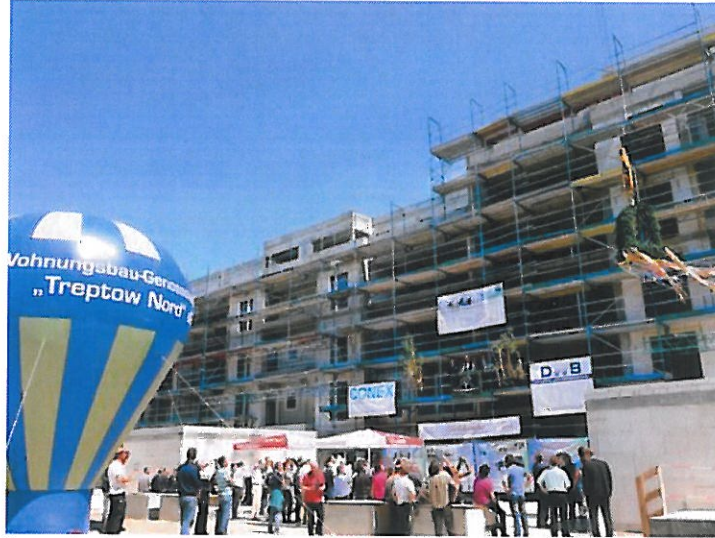
Über dem Rohbau des neuen Heidekamp-Ecks ging der Richtkranz hoch. Foto: Ralf Drescher
